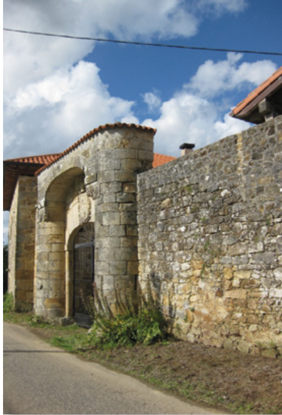
Muro que une la Casa y la Capilla.
