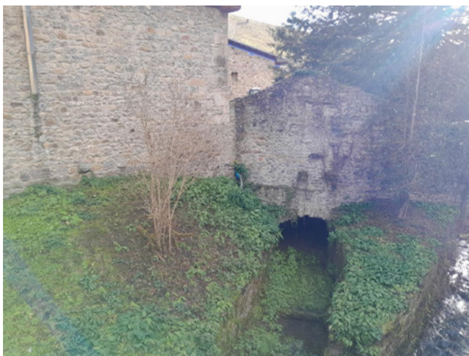
Canal de “desbarcie” de la antigua ferrería y después fábrica de harinas, en Santiurde de Reinosa.
