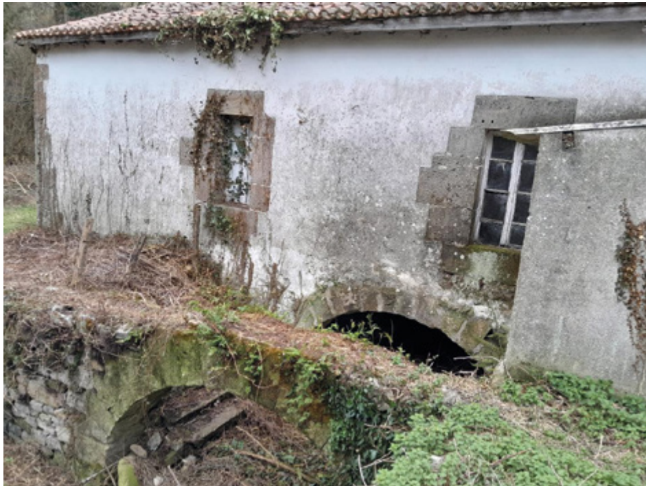
Fábrica de harinas La Dominica en Santiurde de Reinosa.
