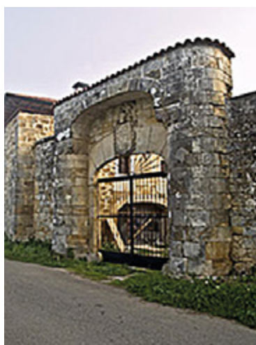
Puerta principal de acceso.
