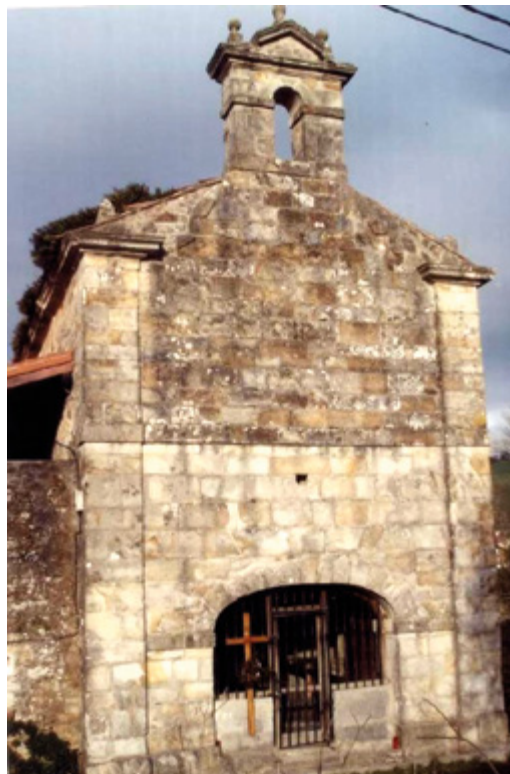
Vista exterior de la Capilla.
